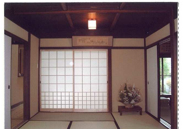
取次ぎの間 建具と壁を明るい基調で仕上げる。ケヤキの大引き天井は補修にとどめそのまま残す。
