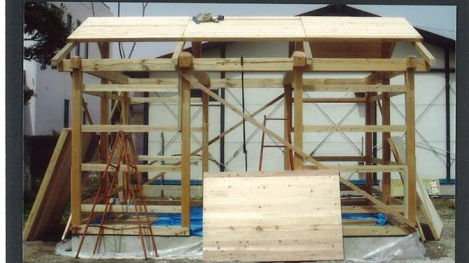
屋根ハネル取り付け（着脱可能）大工さん + 職員
