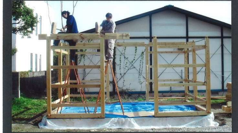
建て方（木軸組み金物不使用）大工さん
