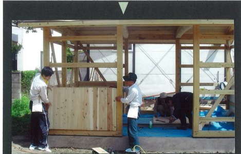
壁ハネル取り付け（着脱可能）大工さん + 職員
