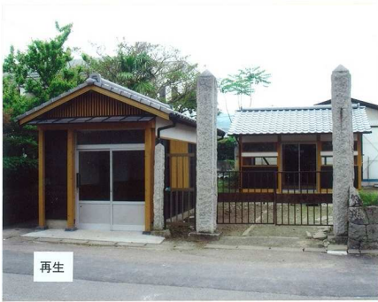
南側 外観 昔から残っていた倉庫と石の門柱も案内所の一部として再生
